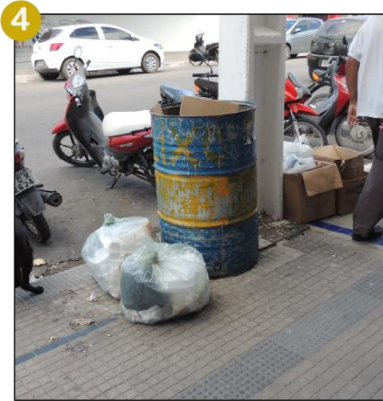
Carência na disposição de lixeiras por toda extensão da via, ocasionando acúmulo de lixo nos pontos que se encontram.
