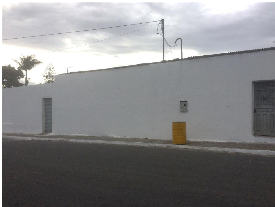
Figura 9 - Fachada do Clube Caobe na Rua Napoleão Laureano, Esperança – PB
